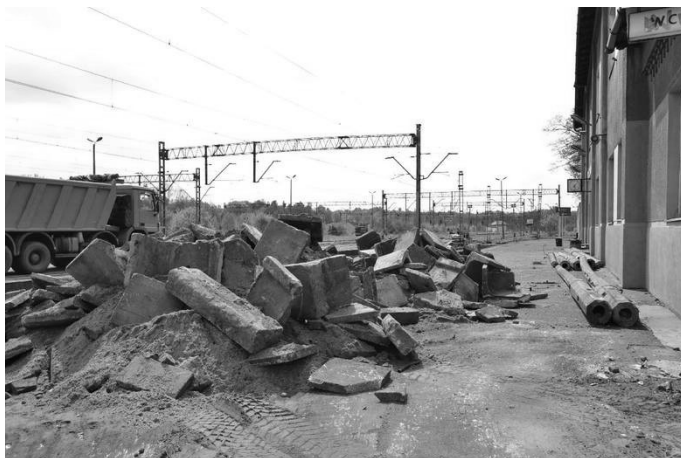
Rys. 1. Prace remontowe na odcinku Rybnik Towarowy - Chałupki
