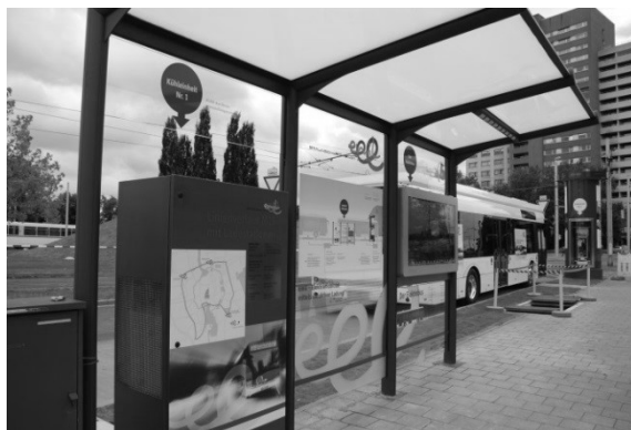
Rys. 6. Ukończony przystanek autobusowy wraz z całą niezbędną infrastrukturą.
